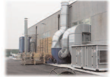
Pompes d'aspiration des résidus VOC (Volatile Organic Compound)
